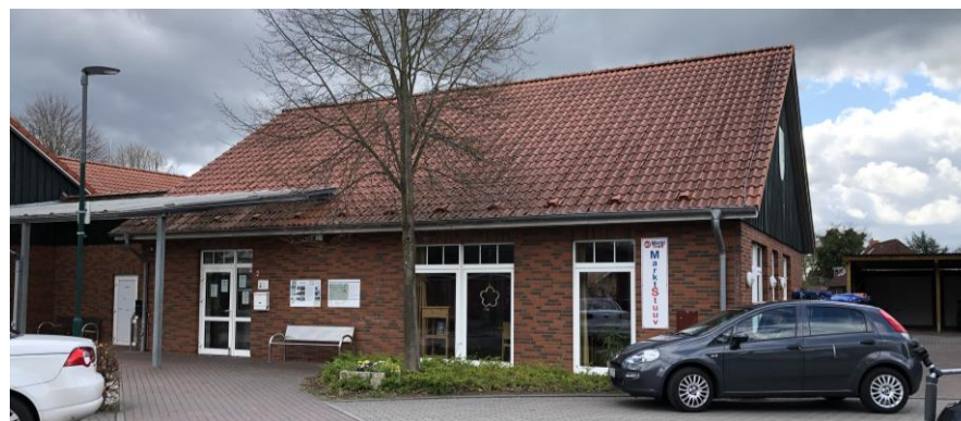
Abbildung 25: Ensemble Marktstuuw und Kindergarten (CIMA 2021)
