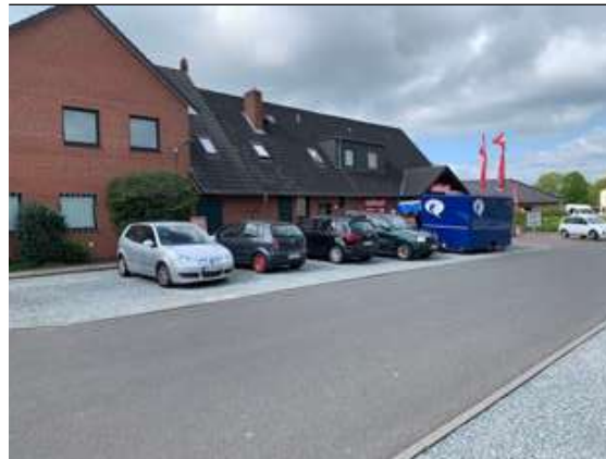
Hohn, Ortslage: Altobjekt Nahkauf Stiefel (Aufgabe zugunsten Neubauvorhaben)
