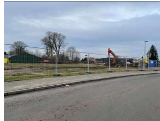
Hohn, Ortslage: Supermarkt-Neubau an der zentralen Ortsdurchfahrt
